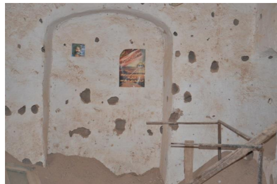
شکل ۱. تخریب منازل روستا در اثر حمله موش‌ها
